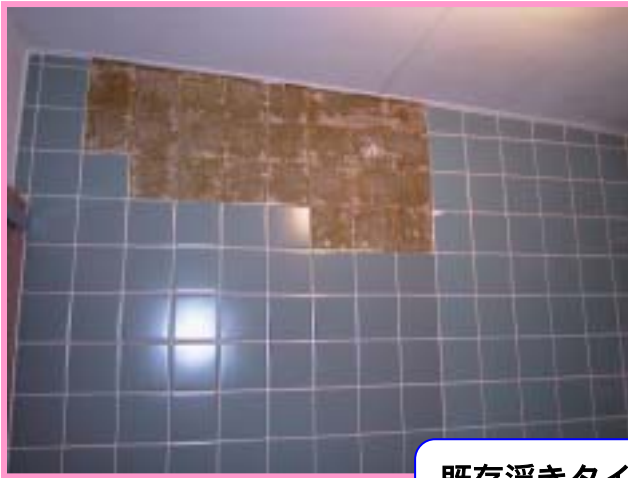
既存浮きタイル部 撤去 レベル下地造り
