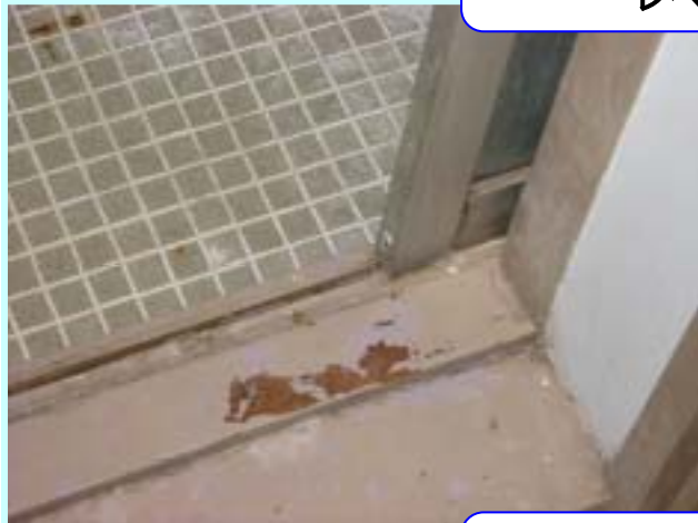
現状引き戸 下腐食部造作 新規アルミドア取付
