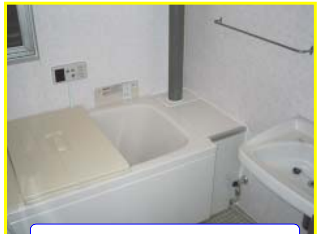
パネル貼り仕上げ工事
