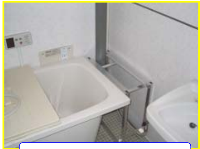
排水配管スペース仕上げ工事
