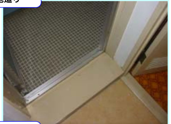
現状引き戸 下腐食部造作 新規アルミドア取付
