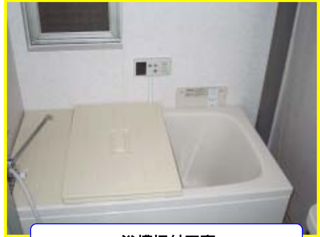
浴槽据付工事
